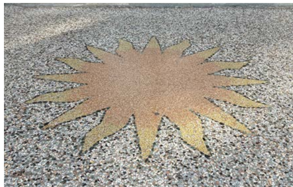
Figura 13 – Particolare del pavimento alla veneziana di un portico di Bologna
