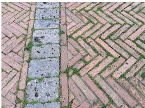
Figura 1 – Particolare della pavimentazione trecentesca in mattoni a spina di pesce e fasce in pietra grigia di Piazza del Campo, Siena
