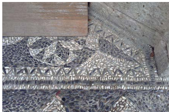
Figura 10 – Particolare del rissêu (o acciottolato ligure a disegni) del sagrato della chiesa di Santa Maria Assunta a Finalpia (Finale Ligure, Savona), datato 1845
