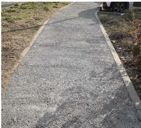
Figura 20 – Esempio di vialetto pedonale con pavimentazione in conglomerato bituminoso
