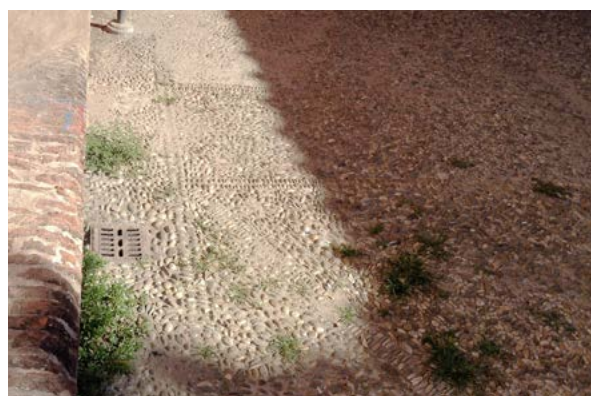
Figura 11 – Particolare dell'acciottolato antistante la chiesa di Santa Maria del Baraccano a Bologna, di aspetto simile alla rizzata lombarda
