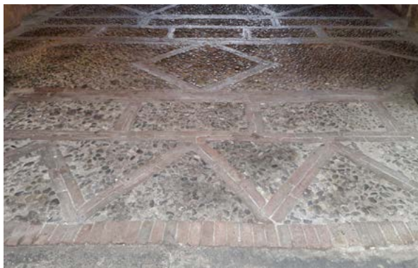
Figura 12 – Particolare di un acciottolato settecentesco con decorazioni geometriche di mattoni posti per coltello, tipico dell'Emilia
