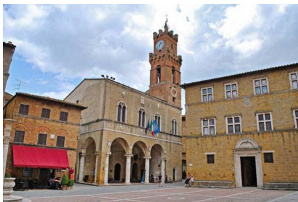
Figura 2 – La pavimentazione in mattoni a spina di pesce e fasce in pietra bianca definisce un ampio reticolo geometrico a maglie rettangolari che sottolinea la scansione prospettica della composizione di Piazza Pio II, Pienza
